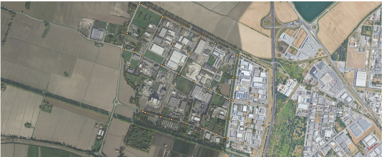
Fig. 14 – Pozzetti di linea fognari rilevati
